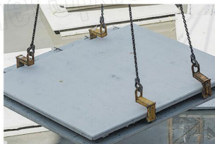
水泥预制件 Concrete prefabricated parts
